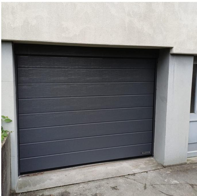
Umbau, Hörmann Garagen-Sektionaltor RenoMatic 42 mit einer PU-Blende in CH703 Anthrazit metallic, M-Sicke Woodgrain
