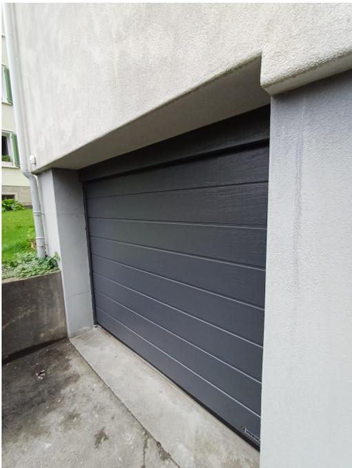
Umbau, Hörmann Garagen-Sektionaltor RenoMatic 42 mit einer PU-Blende in CH703 Anthrazit metallic, M-Sicke Woodgrain
