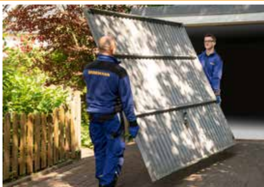
Ausbau und umweltgerechte Entsorgung
